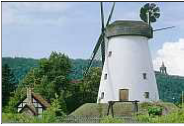
Mühle Holzhausen an der Porta Westfalica
