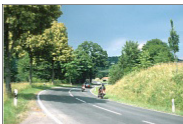
B 276 zwischen Schotten & Laubach
