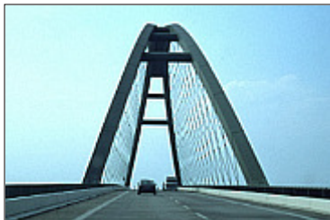
Vogelfluglinie: Brücke über den Fehmarnsund
